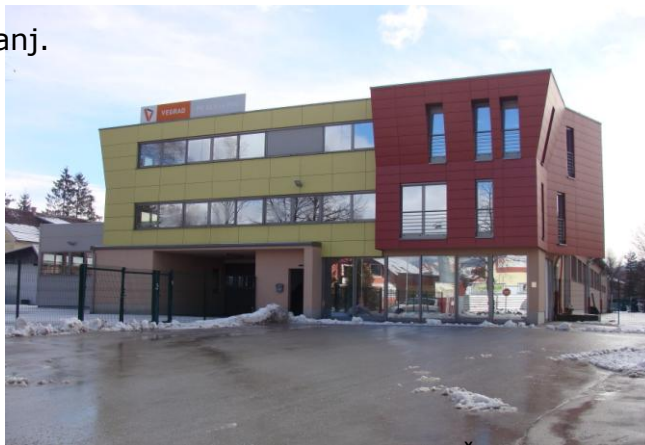
Industrijski kompleks Montal, k.o. Šoštanj
